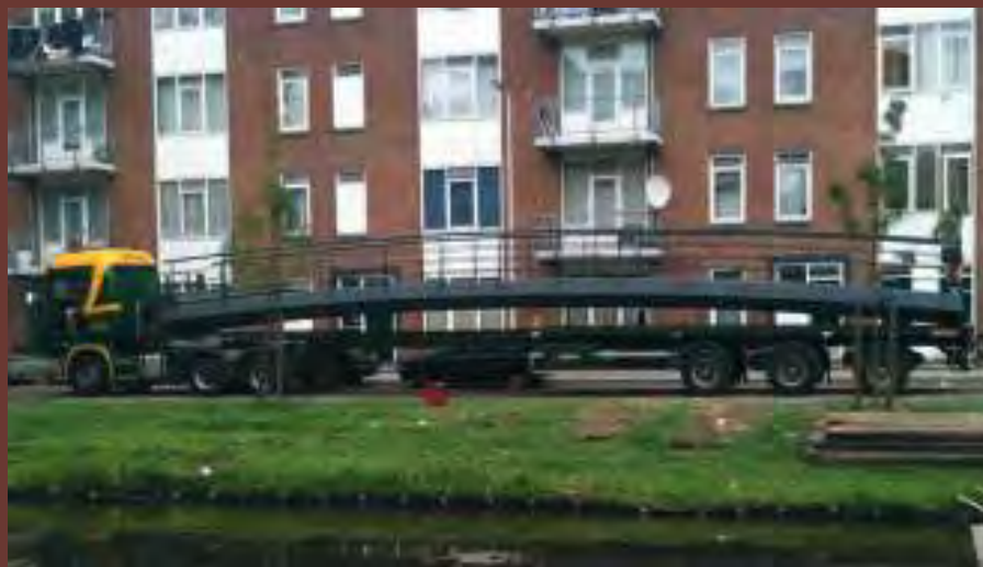
Foto: Transport composietbrug (gemeente Rotterdam)
